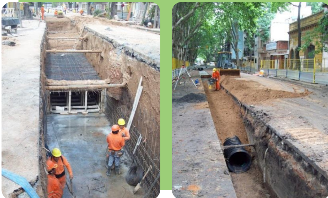
Fig 7.3 - Construcción de conductos secundarios con tecnología tradicional.
